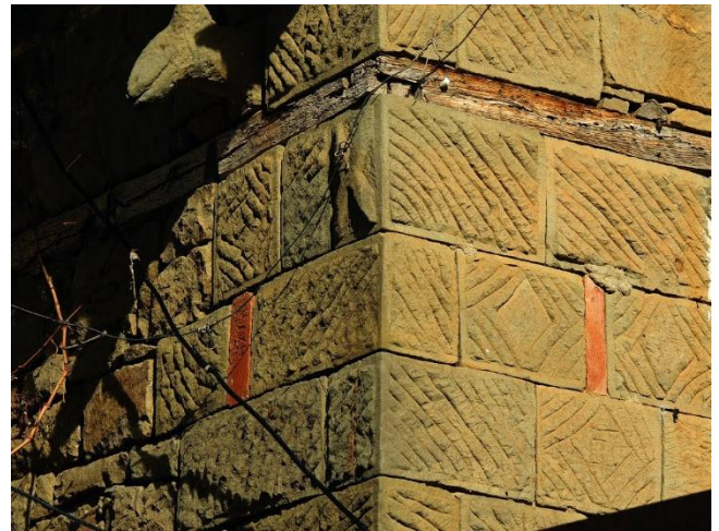
Fig. 12 Detaj i punimit të mureve të banesave në fshatin Slabinjë
